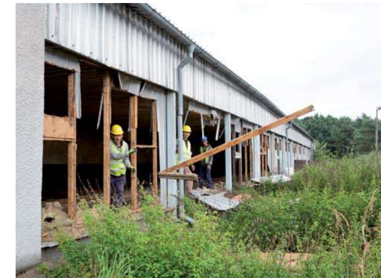
Fotodokumentace průběhu demolic budov bývalého vepřína, 15. 9. 2022 / Documentation in photographs of the course of the demolition of the buildings of the defunct farm, 15 September 2022
